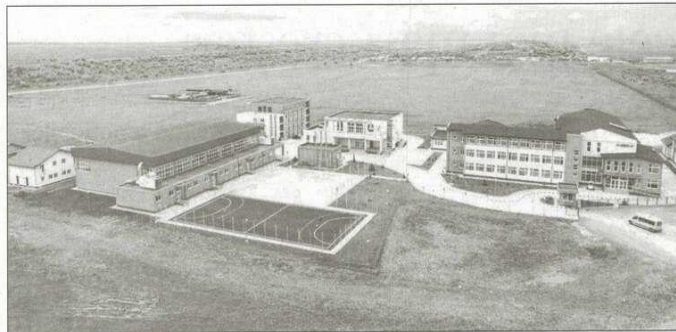
Campusul școlar Cumpăna (jud. Constanța) a fost construit în urma unei investiții de peste 8 milioane de euro din fonduri europene și are o capacitate de școlarizare de circa 850 de elevi. Suprafața campusului este de aproximativ 17.000 de metri pătrați.
